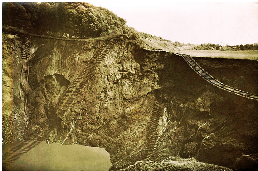
Blick nach Osten, rechts das Hilfsgleis zum Verfüllen
