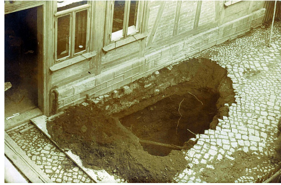
Wohnhaus Osterwiecker Straße
